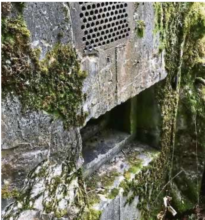
Luke (unten) und Gitter zur Be- und Entlüftung.
