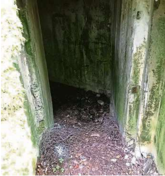
Eingang zu einem der Bunker bei Freigericht-Horbach. Das ?Innere ist nicht mehr zugänglich.
